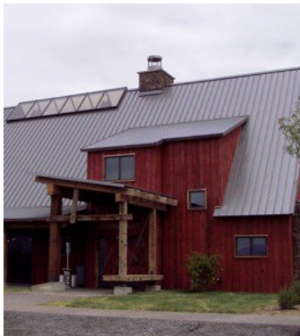
Figura 1 – Telhado de aço bonderizado sem pintura (cortesia da Steelscape Inc.)
