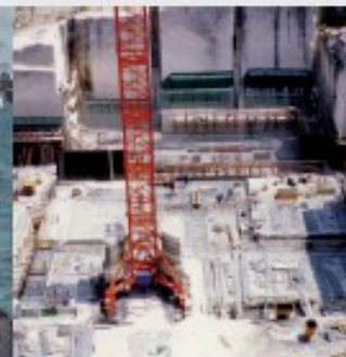
Central de Energia de Tynes Bay
